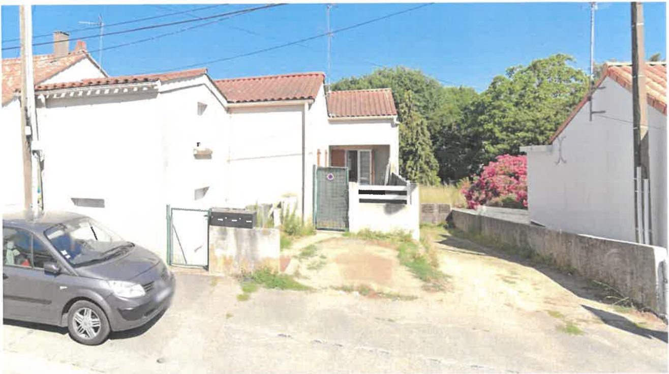
Cliché du bien sinistré avant incendie, extrait de STREET VIEW – JUILLET 2022
