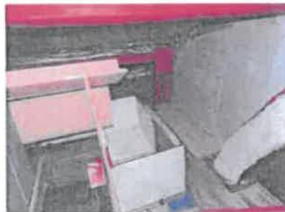
Il a été observé la présence d'une poubelle servant à récupérer l'eau de pluie liée à une infiltration de toiture.
