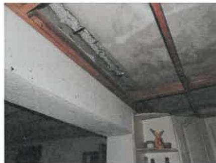
Par dessus ces faux-plafonds, une structure bois permet de poser un plancher bois à l'étage. Ces pièces sont en cours de travail.
