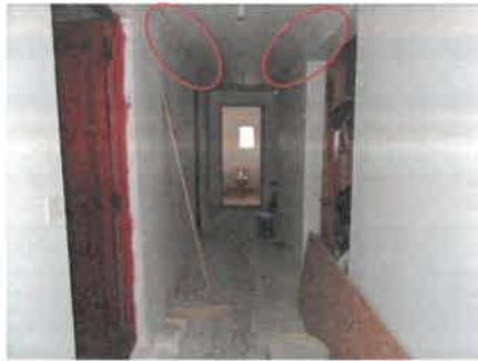
8) Quelques lames de lambris au plafond du couloir sont tombées à moins que cela soit lié à une dépose par les pompiers pour vérifier qu'il n'y avait pas de feu couvant.
